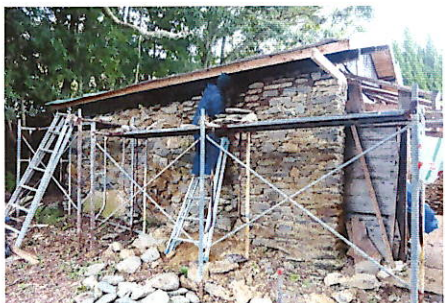
ネリベイ壁の修復
