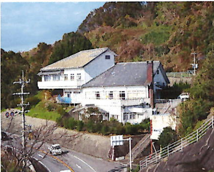
解体前の開陽山荘
