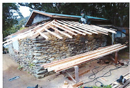
藁葺き屋根の修復
