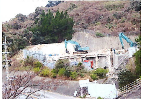
解体が進む開陽山荘
